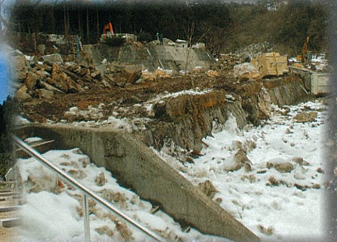
解体中の小学校
